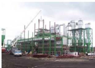
Construcción Planta Sinterizadora al 15 de Junio de 2005
